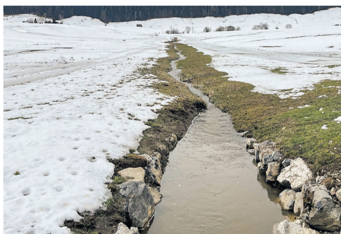
Der Rotenbach erhält eine Aufwertung und wird mehr Platz für Wasser und Leben bieten. Foto: Stefan Keller
